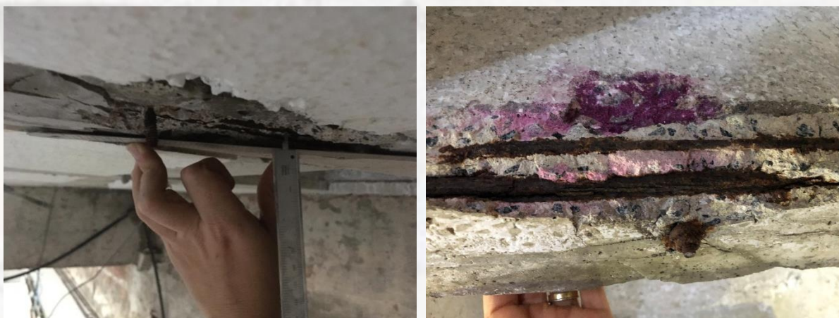
Figura 28 – Profundidade carbonatada x capa de cobrimento da armadura em lajes.
